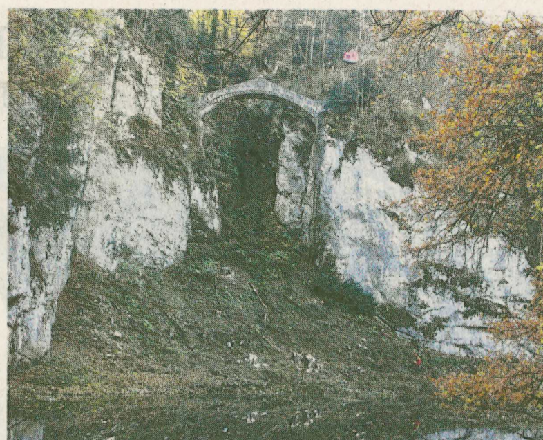
Ein Anblick, der seit Jahrzehnten nicht möglich war: Von der Eremitage ist die Teufelsbrücke nach gezielten Baumfällarbeiten wieder einsehbar. Mit dem Seilkran (oben im Bild) wurden die Bäume abtransportiert.
