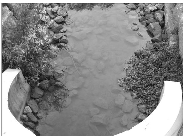
**Abb. 2:** Verschlammter Tosbereich am HRB Insensbach S43. Die Einengung des Mittelwasserbetts könnte hier Abhilfe schaffen.
