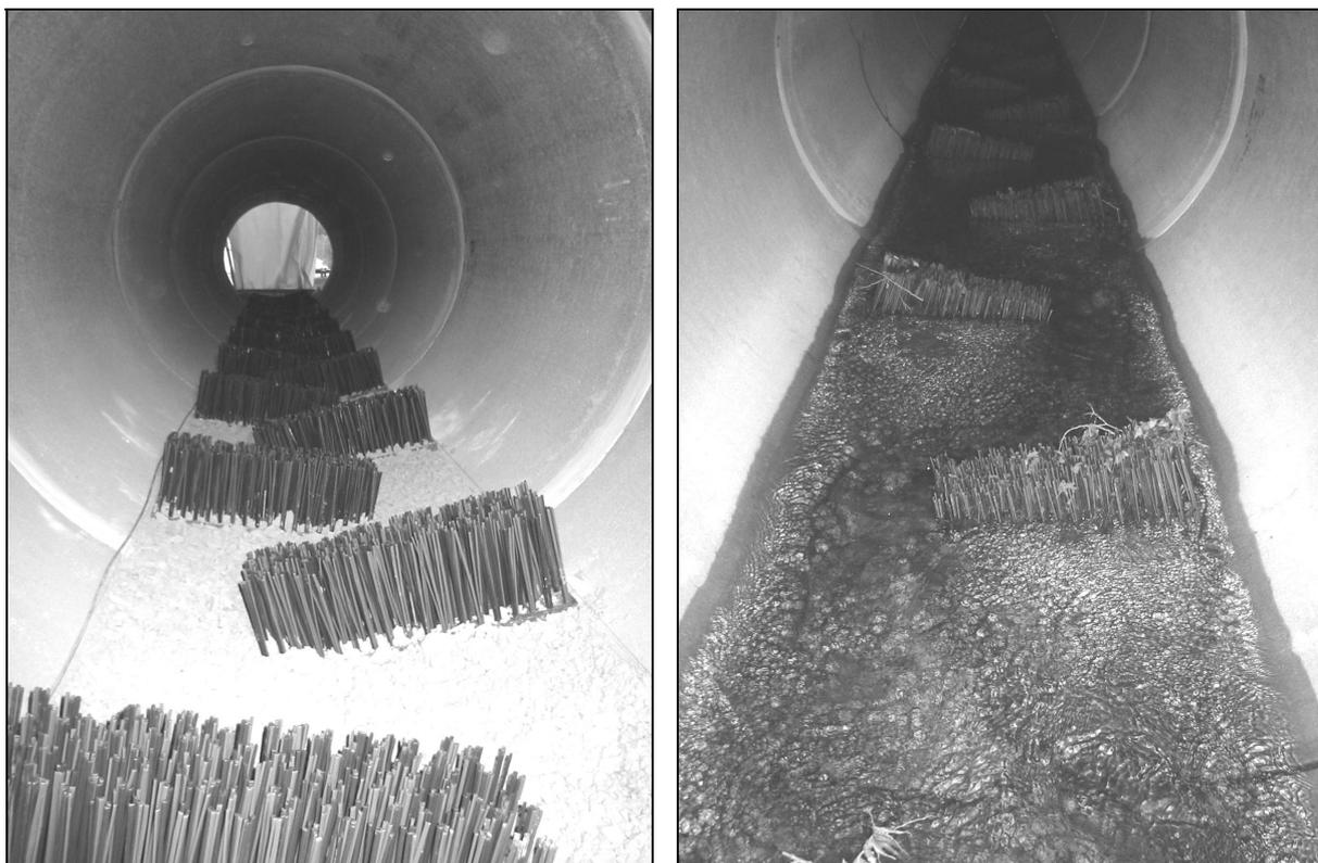
**Abb. 2: Borsten in einem Grundablassstollen und Stollen in Betrieb.**
