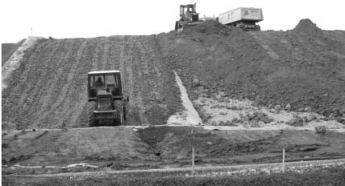
Abbildung 3: Einbau der Rekultivierungsschicht in die Lysimeterfelder im November 2000; links: Verdichtung mit der Stachelwalze im K-Feld, rechts: Vor-Kopf-Einschieben mit leichter Raupe im U-Feld
