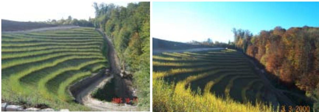
Abbildung 10: Steilbereich mit Buschlagen ca. 6 Monate nach Einbau (Oktober 2005)
