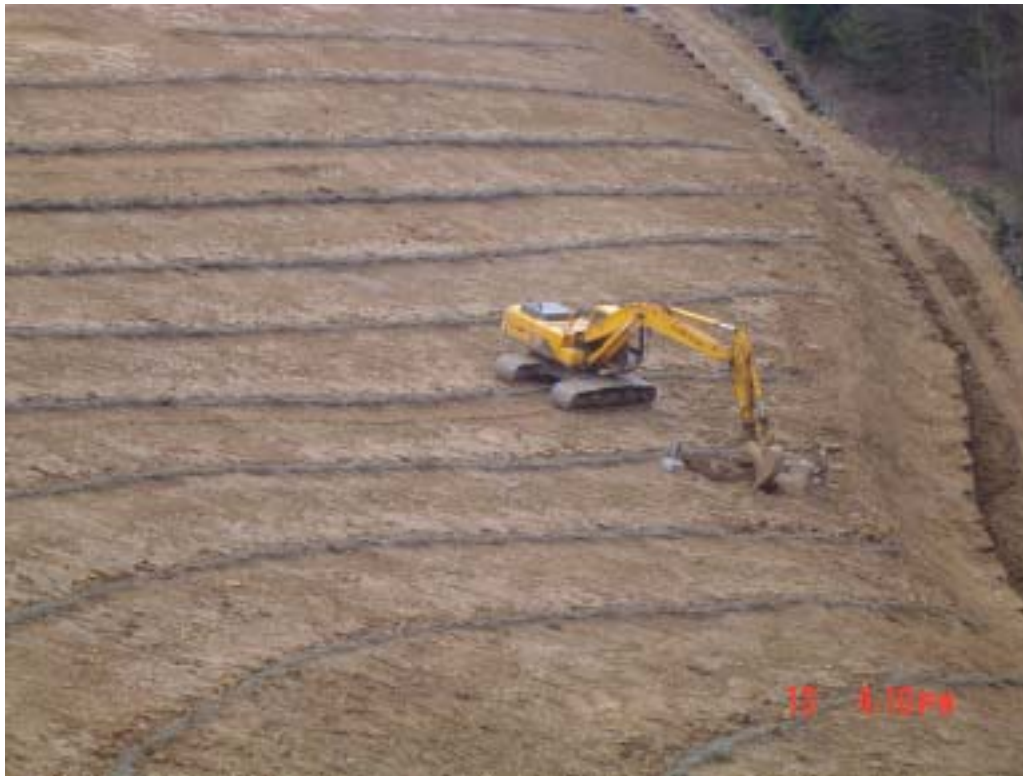
Abbildung 8: Ansicht Steilbereich mit Buschlagen direkt nach Einbau
