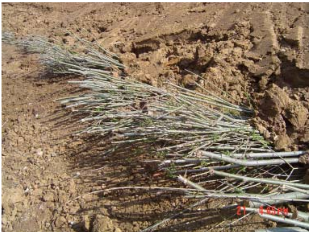
Abbildung 9: Austreibende Buschlagen ca. 2 Wochen nach Einbau (21.04.2005)
