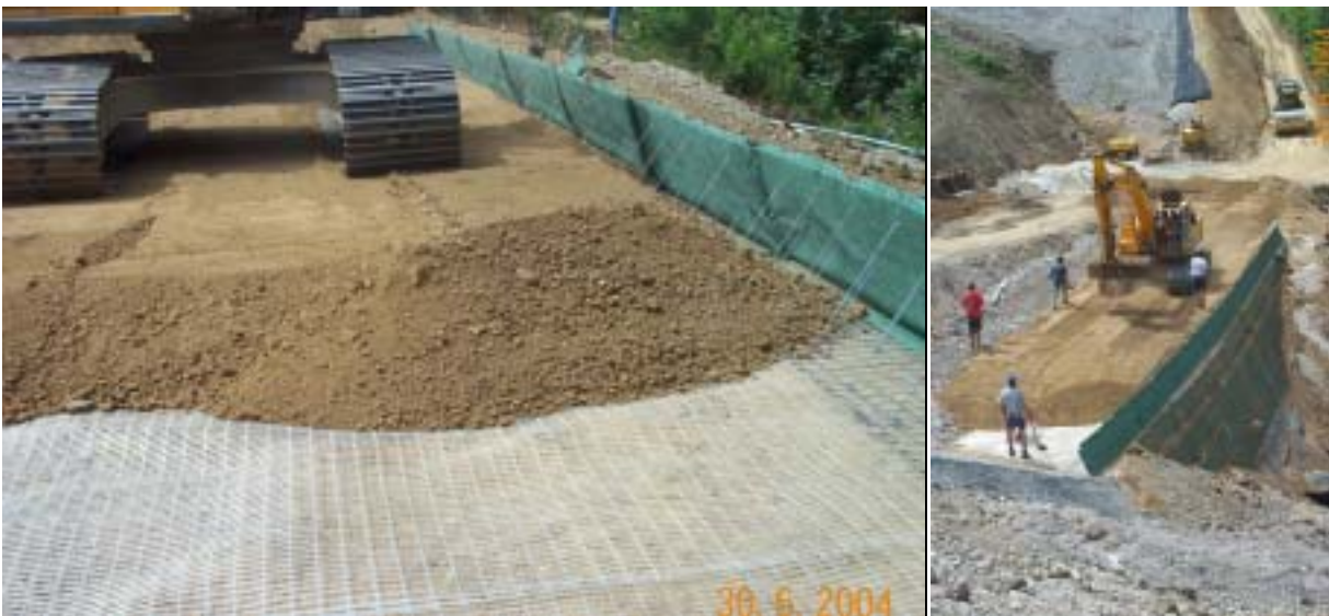
Abbildung 3: Einbau der Polsterwand
