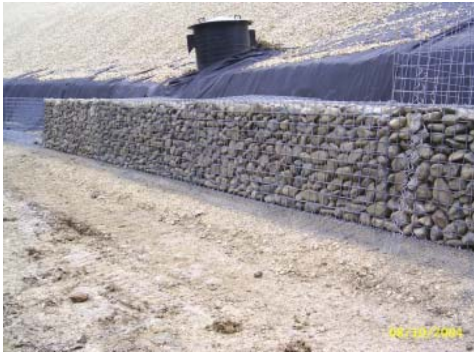
Abbildung 4: Gabionenwand zur Abstützung der Rekultivierungsschicht am Fuß des Steilbereichs
