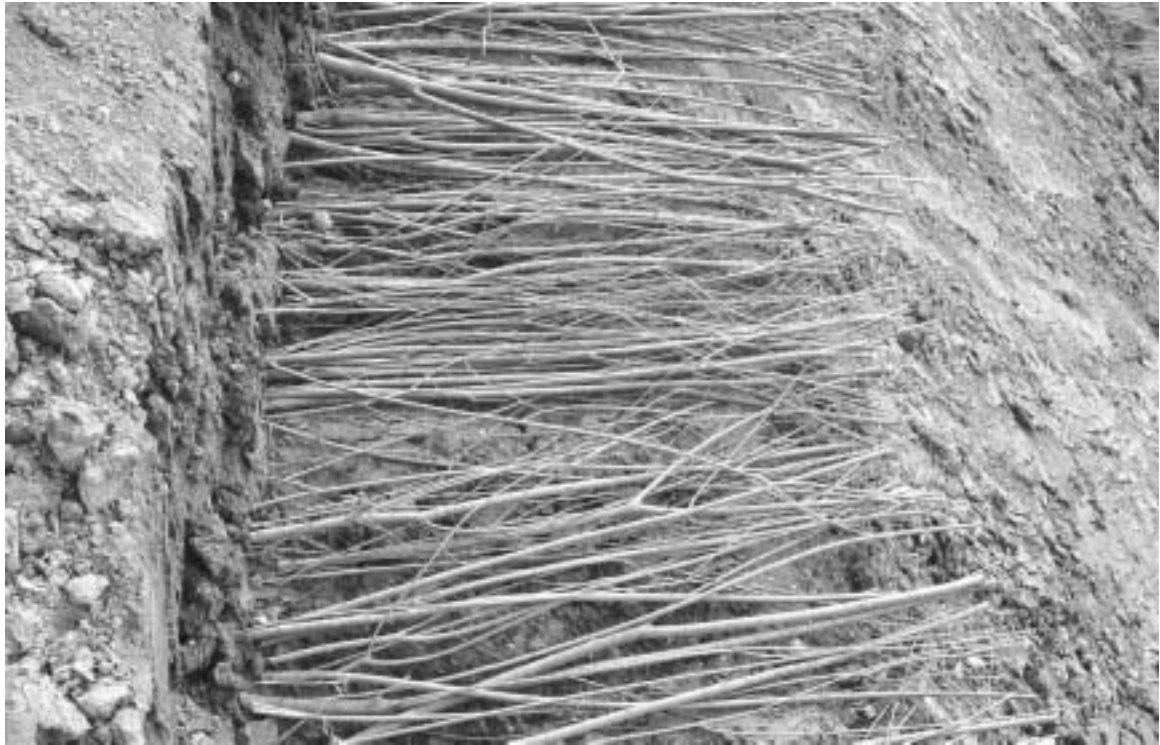
Abbildung 3: Einbau einer Buschlage. Fertig ausgelegte lebende Äste von Weiden ( Salix spec. ) kurz vor dem Abdecken mit Boden. Maßnahme zur Sicherung einer Steilböschung auf der Deponie Blumentobel, Lkr. Esslingen (Foto: König).
