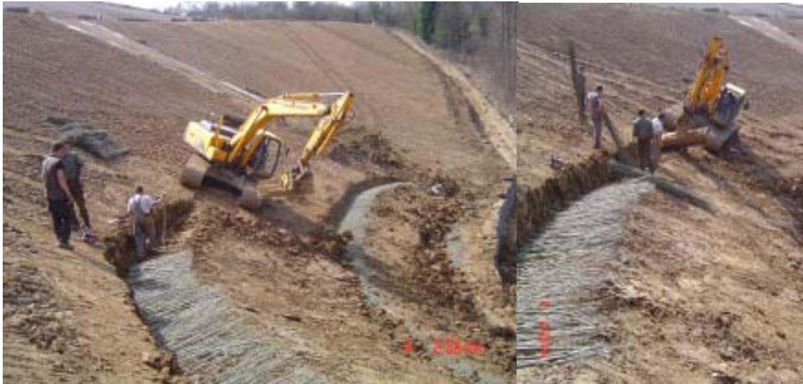
Abbildung 7: Einbau der Buschlagen 4. bis 7. April 2005
