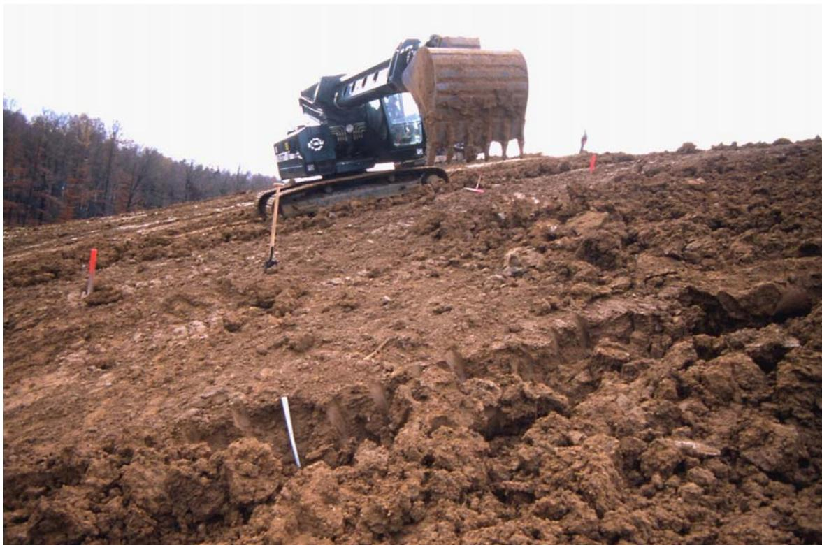
Bild 9: Auflockern des Oberbodens mit dem Teleskopbagger
