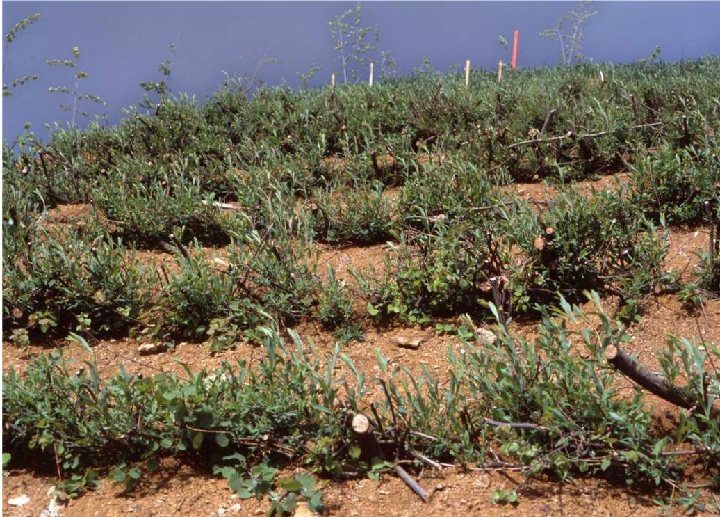
Bild 21: Erste Triebbildung an den im vorangegangenen Dezember im Testfeld eingebauten Buschlagen im Mai 2001. Der Anwuchs erfolgte sehr gleichmäßig und ohne große Lücken. Eine wichtige Voraussetzung für den Erfolg der Maßnahme.
