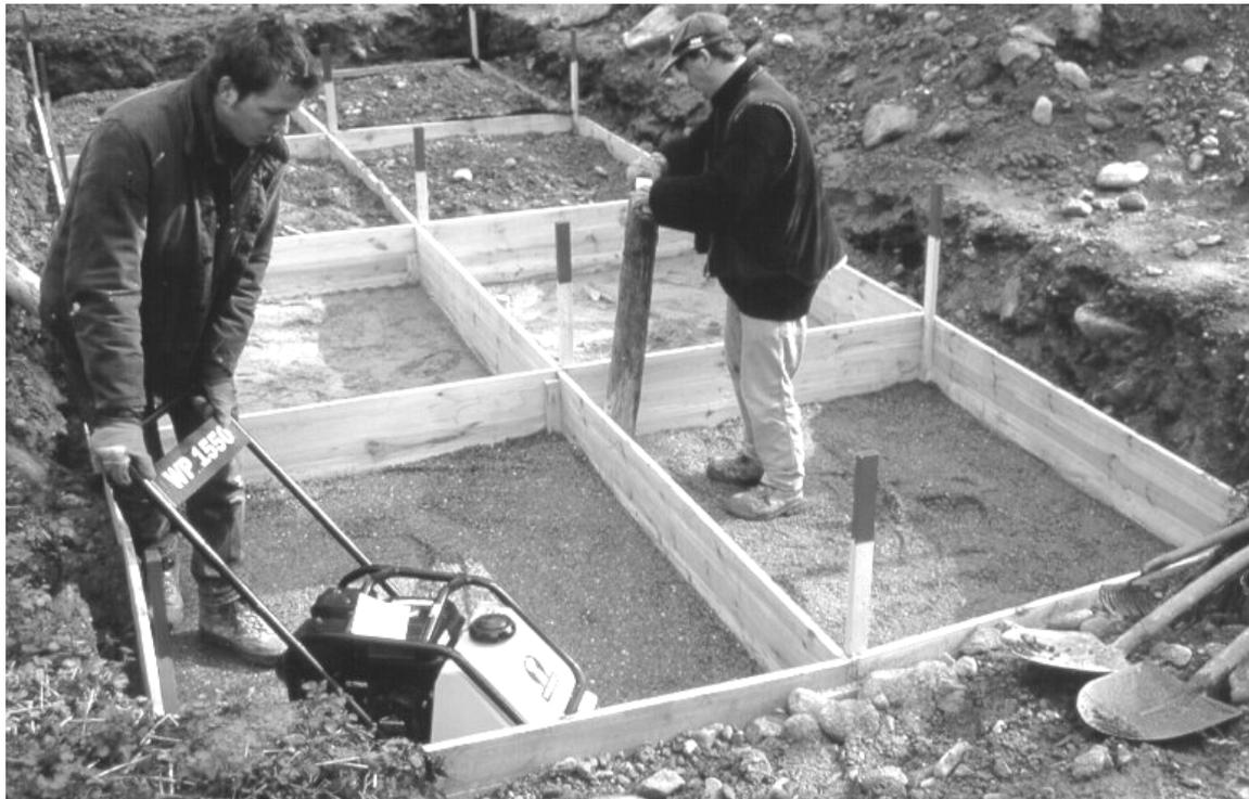
Bild 3: Bau der Wurzelsperren-Testfelder: Verdichten des Recycling-Glassplitts
