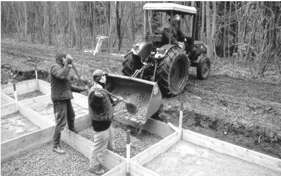
Bild 2: Bau der Wurzelsperren-Testfelder: unverdichtetes Einschütten des Dränbetons
