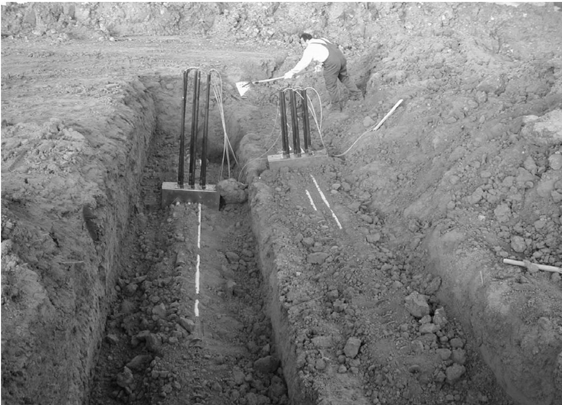
Bild 7: Karlsruher Schertester während des Einbaus in die Rekultivierungsschicht
