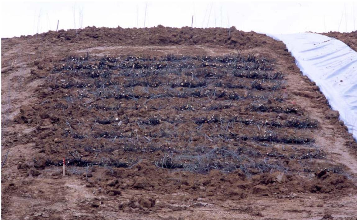
Bild 20: Testfeld mit den eingebauten Buschlagen unmittelbar nach der Fertigstellung im Dezember 2000.
