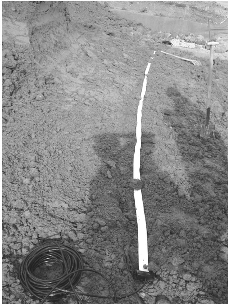
Bild 6: Feuchtemesskabel beim Einbau in der Rekultivierungsschicht
