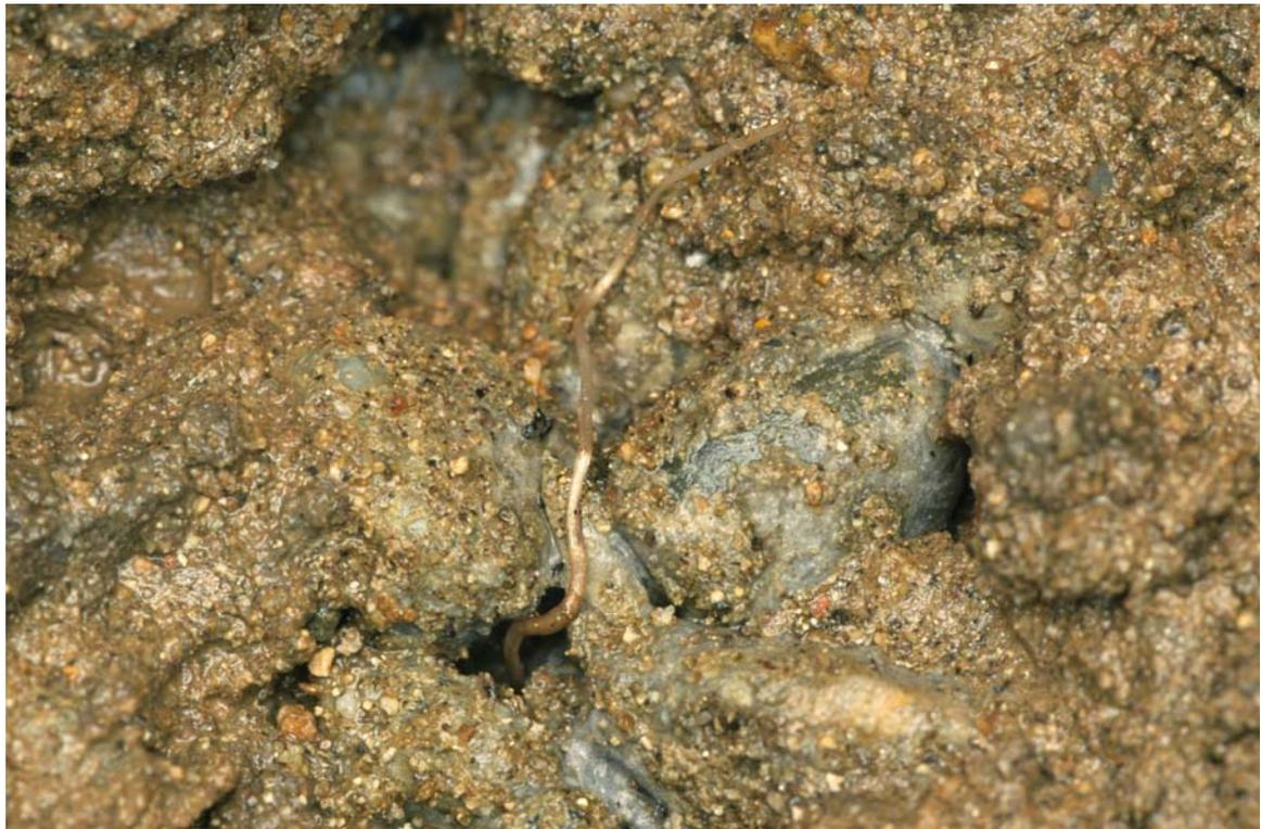
Bild 25: Eine Wurzel wächst in eine Haufwerkspore des Dränbetons ein.
