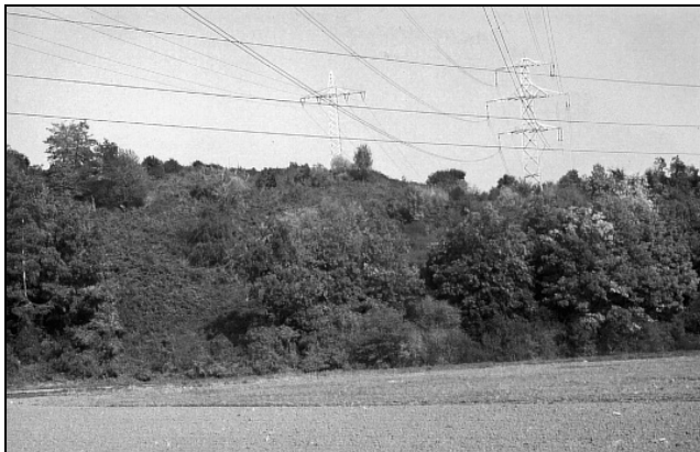
Abbildung 19: Freileitungen östlich der Glemsmühle am rechten Talrand
