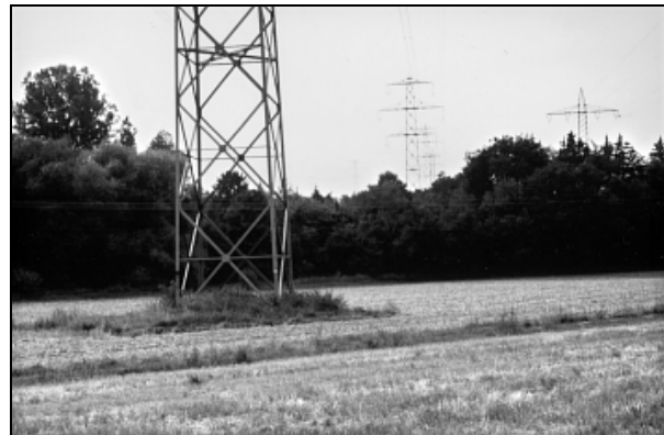
Abbildung 8: Grasreiche Ruderalflur im Bereich eines Mastfußes der RWE-Leitung im Glemstal nahe der Glemsmühle
