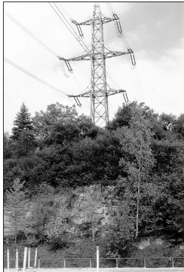
Abbildung 23: RWE-Freileitung am rechten Rand des Münchinger Tales nordwestlich von Münchingen
