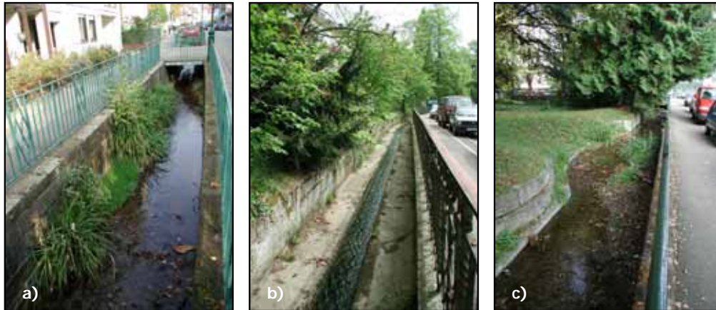
Abb. 53: Profiltypen am Glasbach – (a) Kastenprofil unterhalb des Kirchplatzes, (b) Doppelkastenprofil bei der Hautklinik und (c) Kastenprofil mit Stufen und Böschungsrasen bei der psychiatrischen Klinik
