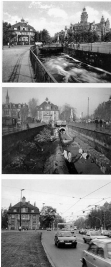
Abb. 6: Verdolung des Pleißemühlgrabens: Zustand 1943 (oben), Überwölbung des verschmutzten Wasserlaufs 1954 (mitte) und Zustand in den 1990ern (unten) (Bilder: NEUE UFER 1997)
