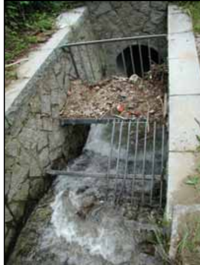
Abb. 62: Querbauwerke am Glasbach – links eine steile Rampe unterhalb der Wintererstraße, rechts eine Rampe mit Rechen und Verrohrung oberhalb der Sonnhalde.
