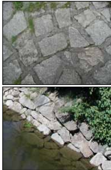
Abb. 27: glattes, verfugtes Natursteinpflaster (oben) und unverfugtes raues Steinpflaster (unten)
