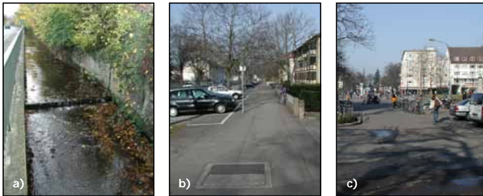
Abb. 101: Entwicklungsräume: a) Rossgässlebach am Güterbahnhof, b) verrohrter Gewerbekanal-Südarml in der Engelberger Straße, c) verdolter Gewerbekanal-Nordarm am Rotteckring
