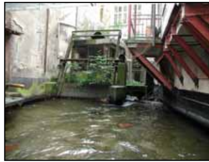
Abb. 94: Kaum zugänglicher Abschnitt des Gewerbekanal-Hauptarms mit der stillgelegten Kraftwerksanlage der ehemaligen „Eisfabrik“
