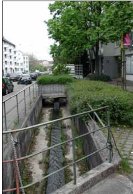
Abb. 93: Der Glasbach an der Habsburgerstrasse - die mit „Begleitgrün“ bepflanzten Betonkästen verstärken noch das trostlose Erscheinungsbild des betonierten Doppelkastenprofils. Lärm und Verkehrsabgase reduzieren die Aufenthaltsqualität auf Null.
