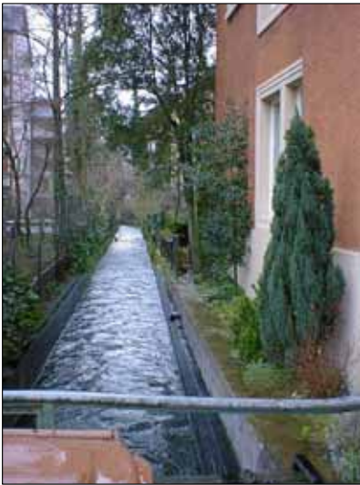
Abb. 70: Schlecht angebundener Gewässerabschnitt des Gewerbekanal-Nordarms nördlich des Rennwegs.
