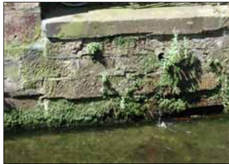
Abb. 25: Diese Sandsteinmauer am Freiburger Gewerbekanal ist nicht nur ein gestalterisch attraktives Element, sondern bietet auch Lebensräume für Pflanzen und Tiere
