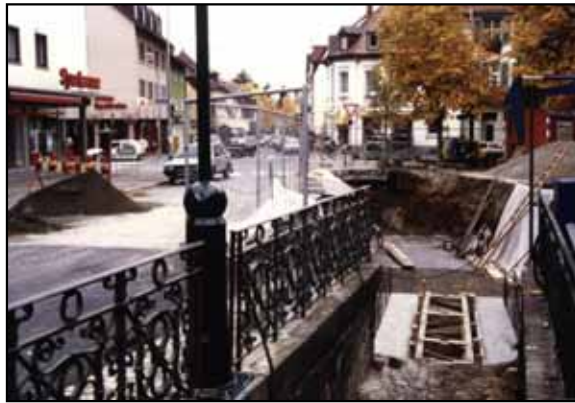
Abb. 99: Öffnung eines verdolten Bachabschnitts und Umgestaltung des Glasbachs am Kirchplatz (Herdern) in den 90ern
