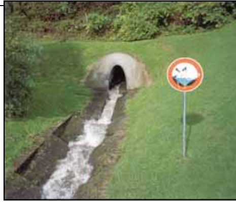
Abb. 13: verbauter und verschmutzter Zulauf der Emscher (Bild: Emscherverband 1999)
