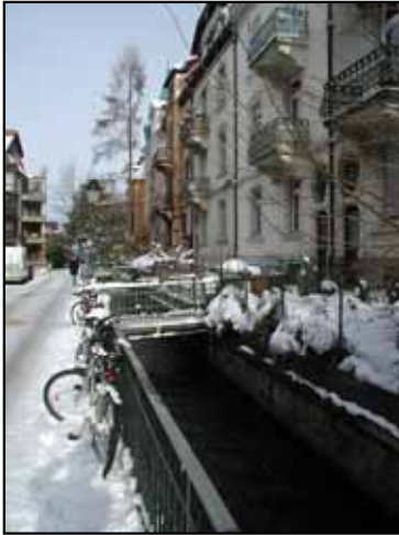
Abb. 84: Der Gewerbekanal in der Gießenstraße weist eine hohe Eigenart auf
