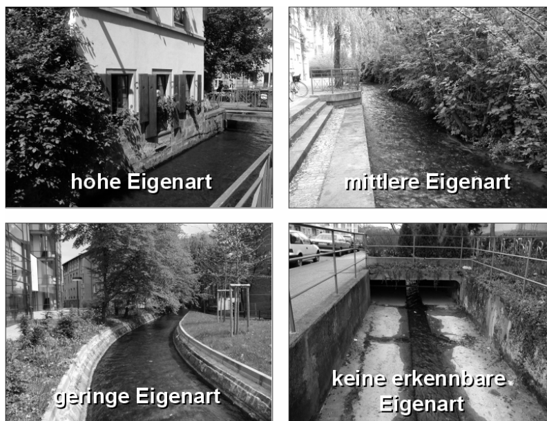
Abb. 40: Beispiele für die vier Kategorien der Eigenart: Links oben der Gewerbekanal in der Gerberau, rechts oben der Gewerbekanal-Südarm im „Grün“, links unten der Gewerbekanal-Nordarm im Institutsviertel und rechts unten der Glasbach in der Habsburgerstraße
