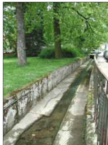
Abb. 104 : Bröckelnder Beton im Glasbach bei der Hautklinik - anstatt den alten Zustand im Zuge einer Sanierung wieder herzustellen, sollte das Profil umgestaltet werden.
