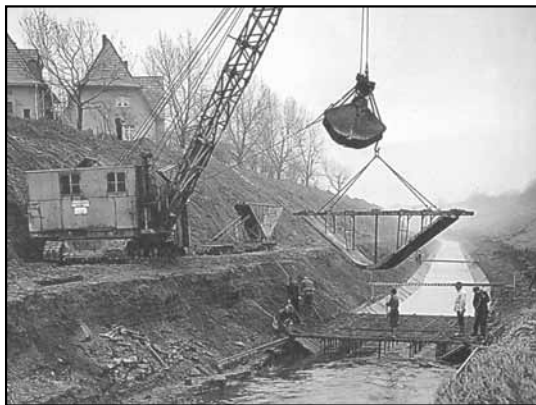
Abb. 7: Ausbau der Emscher 1950 (Bild: EMSCHER-GENOSSENSCHAFT 1999)
