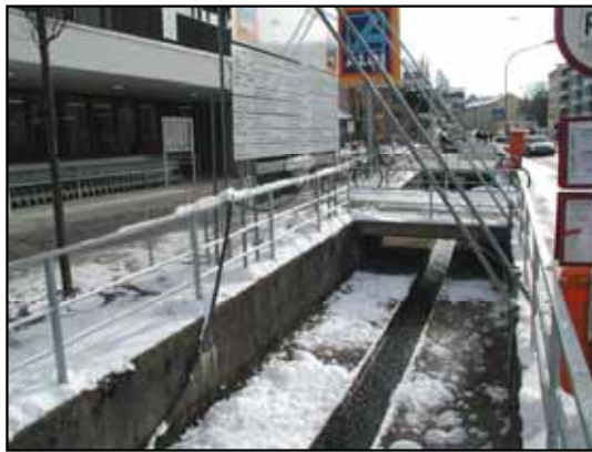
Abb. 134: Chance nicht genutzt – trotz umfangreicher Baumaßnahmen in der unmittelbaren Nachbarschaft wurde der Glasbach an der Habsburgerstraße nicht aufgewertet.
