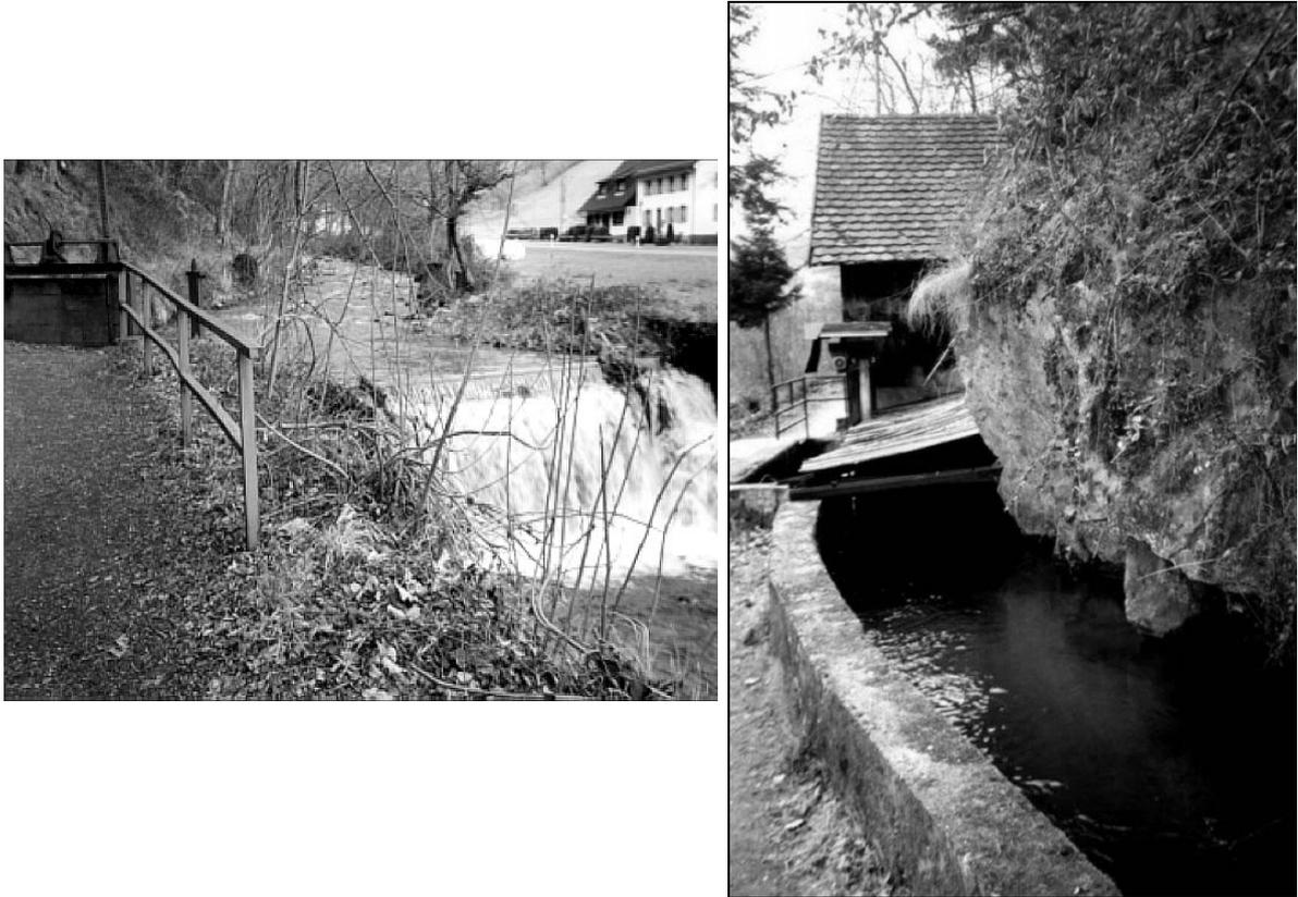
Abb. 6-6: Stauwehr und Hangkanal der ehemaligen Klostermühlen (Aufnahme: K. THIEM)
