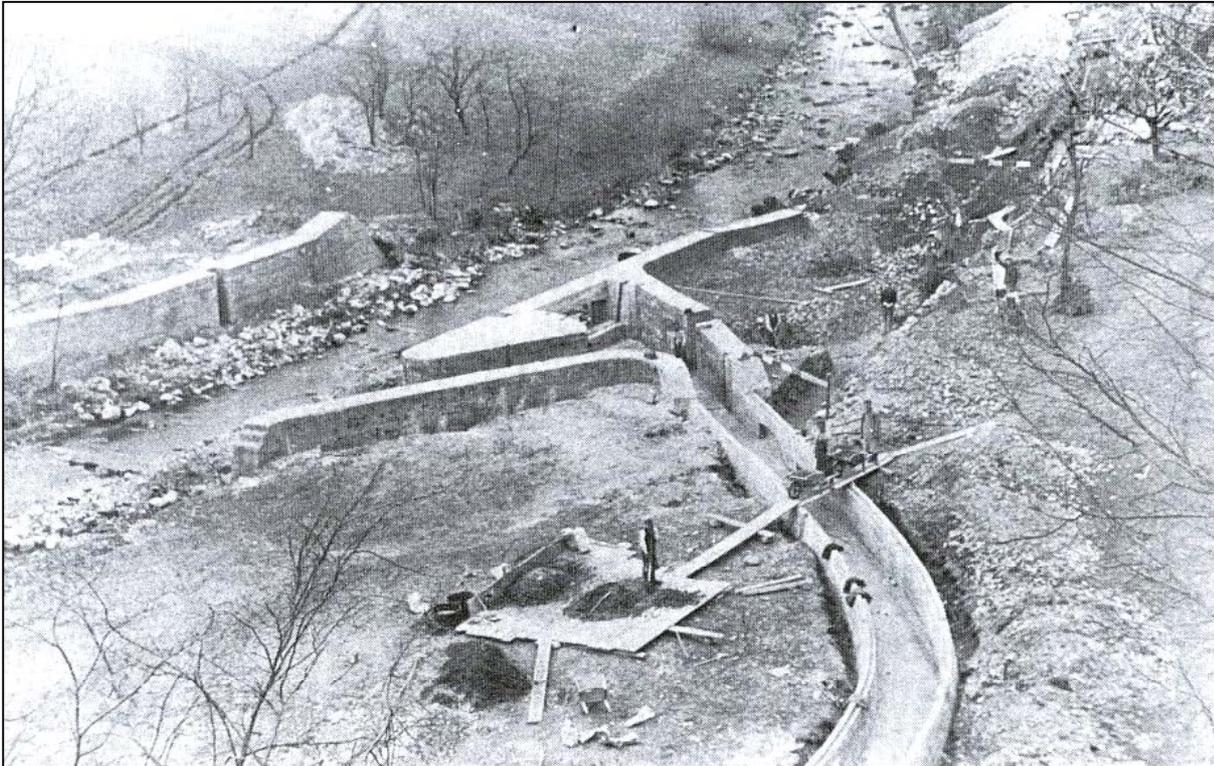
Abb. 6-13: Bau der Wehranlage und des Triebwerkskanals für das Elektrizitätswerk Untermünstertal (LANGE 1991: 85)
