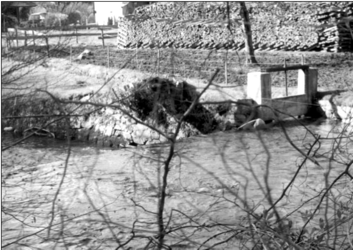
Abb. 6-18: Bewegliche Schütze am Beispiel der Ausleitung Hofsäge (Aufnahme: K. THIEM)
