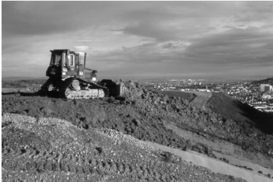
EINBAU DER UNVERDICHTETEN REKULTIVIERUNGSSCHICHT AUF DER DEPONIE
