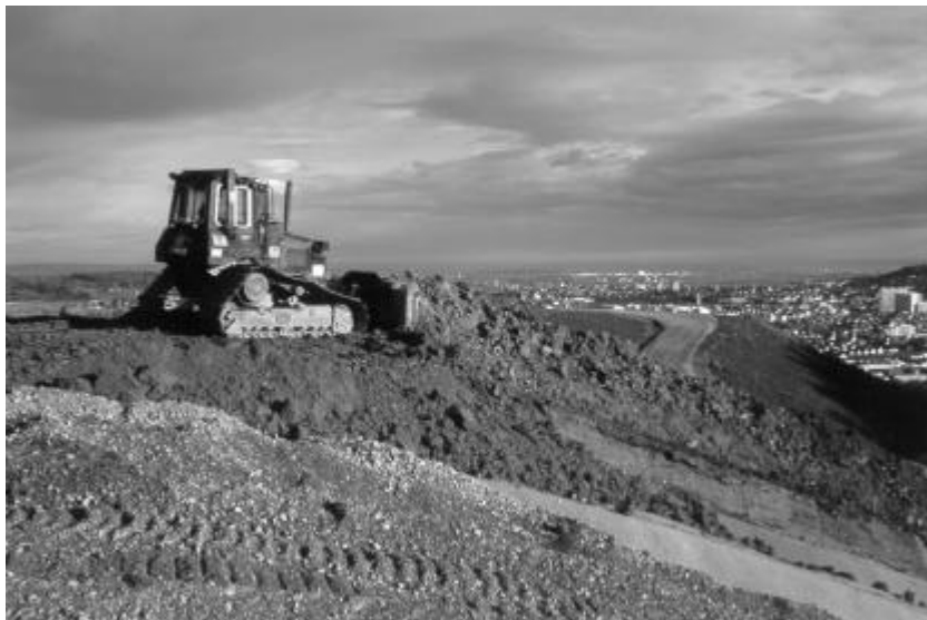
Abbildung 2: Einbau der unverdichteten Rekultivierungsschicht auf der Deponie Neuenburg
