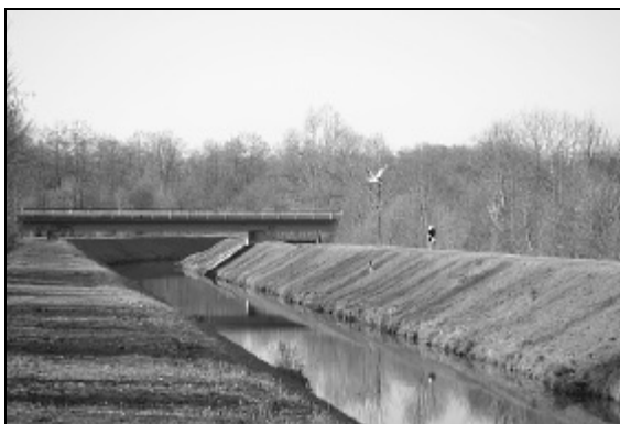
Insgesamt 18 Brücken kreuzen der Lauf des Schutterentlastungskanals. Er verläuft in seinem Trapezprofil (Bild links) von Lahr bis zum Rhein. Ab seinem Eintritt in die Rheinauen (Bild rechts) stellt er vor allem für Libellen einen wichtigen Lebensraum dar.
