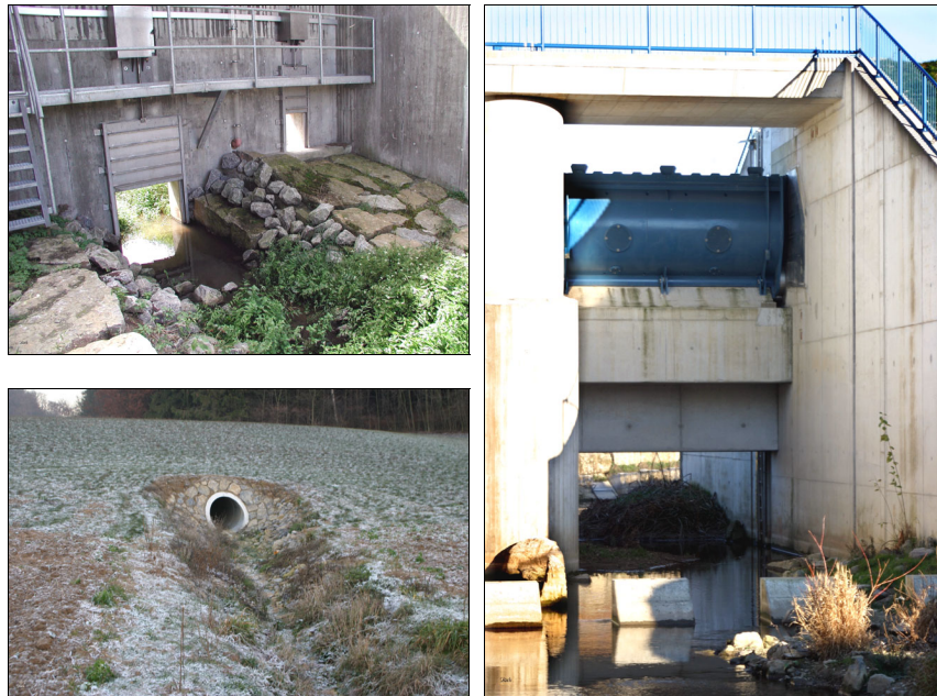
Abbildung 2: Verschiedene Durchlassbauwerke. Oben links - offenes Durchlassbauwerk mit Öko- und Steuerschieber, unten links - Rohrdurchlass, rechts - offenes Bauwerk mit Tiefenschütz und Fischbauchklappe zur Entlastung.
