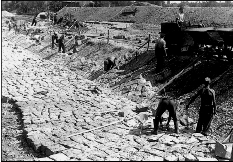
Abb. 6: Die Photos zeigen den Rench-Flutkanal zu unterschiedlichen Zeitpunkten. Der Kanal wurde als Doppeltrapezprofil mit gepflastertem Mittelwasserbett angelegt. Zur Pflasterung wurden Natursteine verwendet. Das Umland des Rench-Flutkanals ist überwiegend von landwirtschaftlichen Flächen geprägt.
