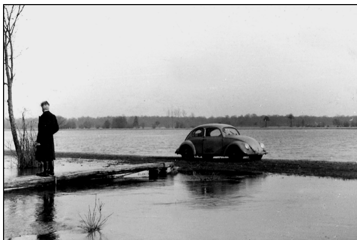
Abb. 3: Hochwasser an der Rench. (Staatsarchiv Freiburg).
