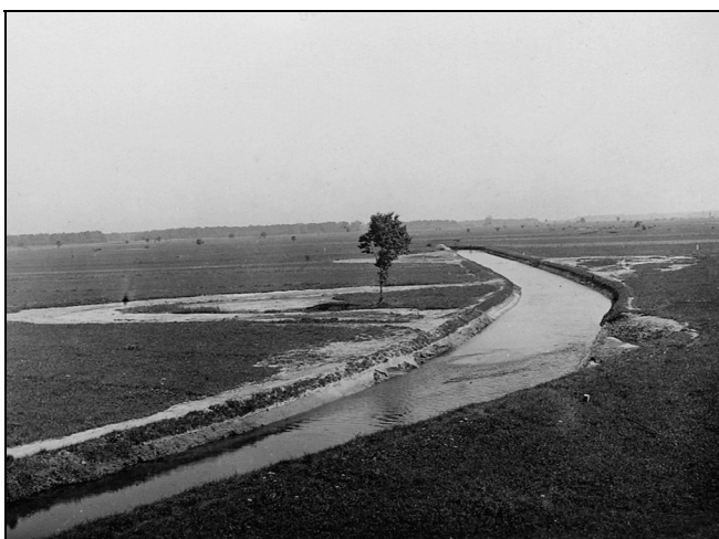
Abb. 4: Die Bilder zeigen den Ausbau der Rench im Maiwaldgebiet. Die weiten Flussschlingen wurden durchbrochen, der Flusslauf begradigt und befestigt (Bilder: Stadtarchiv Freiburg).
