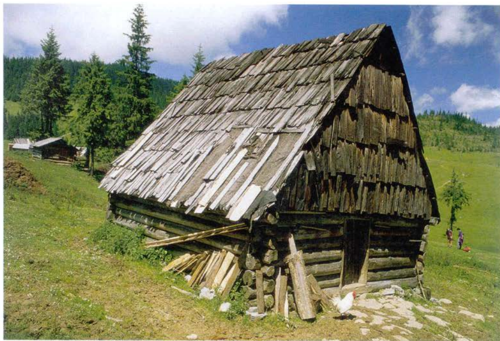
Abb. 4: Eine der letzten erhaltenen, im traditionellen Stil gebauten Sommerhütten („Coliba“) auf der Hochweide. Die in Blockbauweise errichtete, mit Holzschindeln gedeckte Hütte wurde zuletzt von zwei allein stehenden Frauen genutzt. – Călineasa 1998
