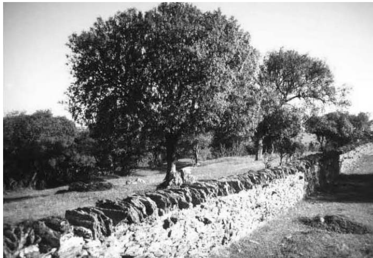
Fig. 5.- Pared de piedra apilada en la finca Pizarro
