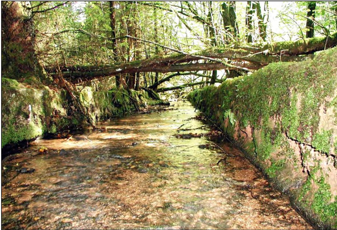
Abb. 15: Triftkanal im Pfälzerwald im massiv befestigten Kastenprofil (Foto: Sandra Röck).
