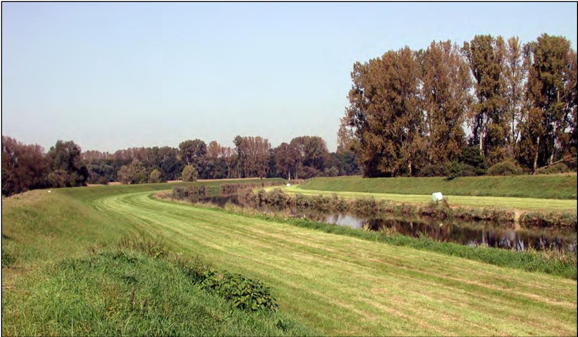
Abb. 13: Der Rench-Flutkanal mit typischem Doppeltrapezprofil (Foto: Sandra Röck).
