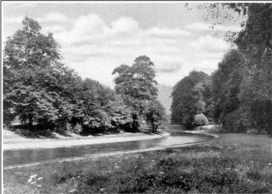
Abb. 46. Regelung der Weißen Elster in Greiz mit guter Linienführung und trefflicher Einbindung des neuen Bettes in die Landschaft
